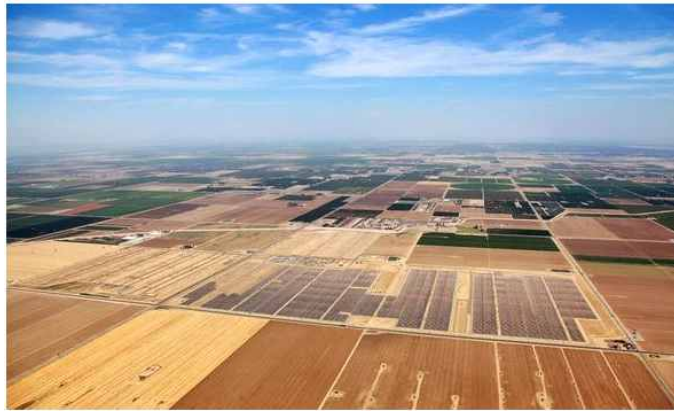
[건설 중인 Regulus Solar Plant 외관]
