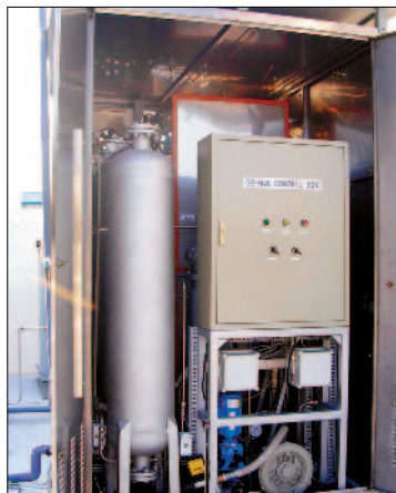
▲ 리포머 시스템 모듈 (Reformer System Module)
