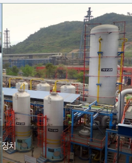
200 kg/day급 H 2 정제 시스템 [Footprint: 2.6m 2 , 수소 회수율: 90%, 수소 순도: >99.999%]
