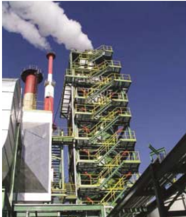
▲ 연소배가스 내 CO 2 연속흡수분리 장치 (Continuous Absorption Apparatus for CO 2 Separation from Flue Gas)
